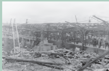
空襲で焼けた八王子駅 東京都八王子市 昭和20年8月4日 石川光陽撮影
